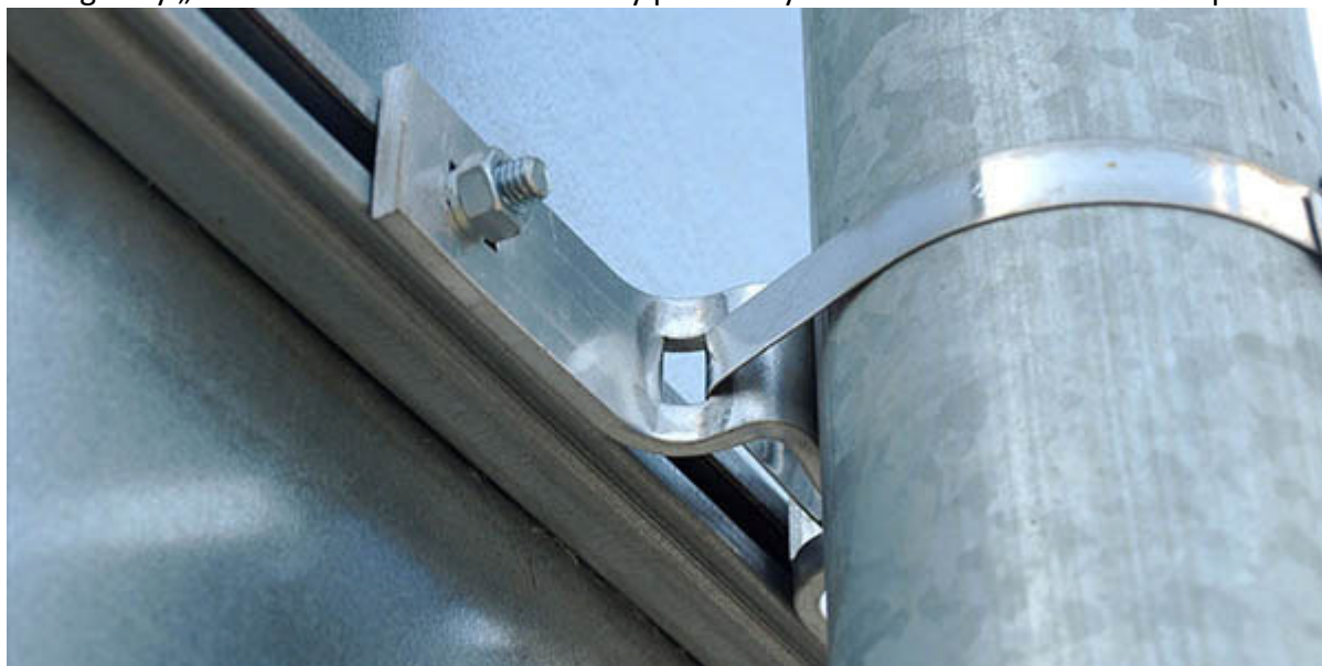
Obrázek 7 Příklad kotvení pomocí pásku, zdroj: http://www.silverton.cz/images/podklady/znackymorava/bandimex.jpg
